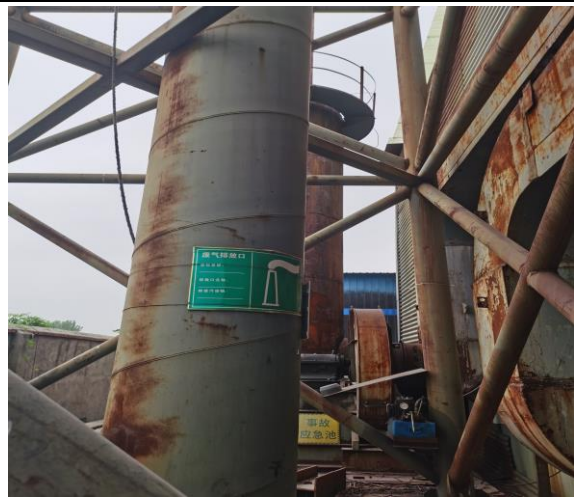
图 3-10 排气筒标识标牌
