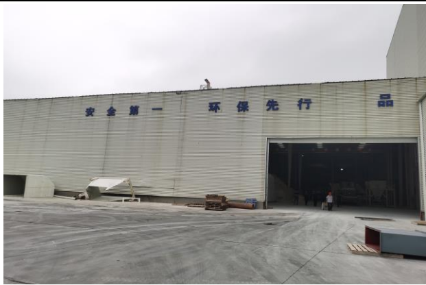
图 3-3 废气处理设施(排气筒)
